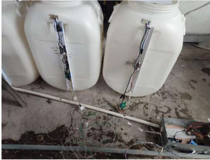
Figura 7. Conexión de los sensores, actuadores y microcontroladores
